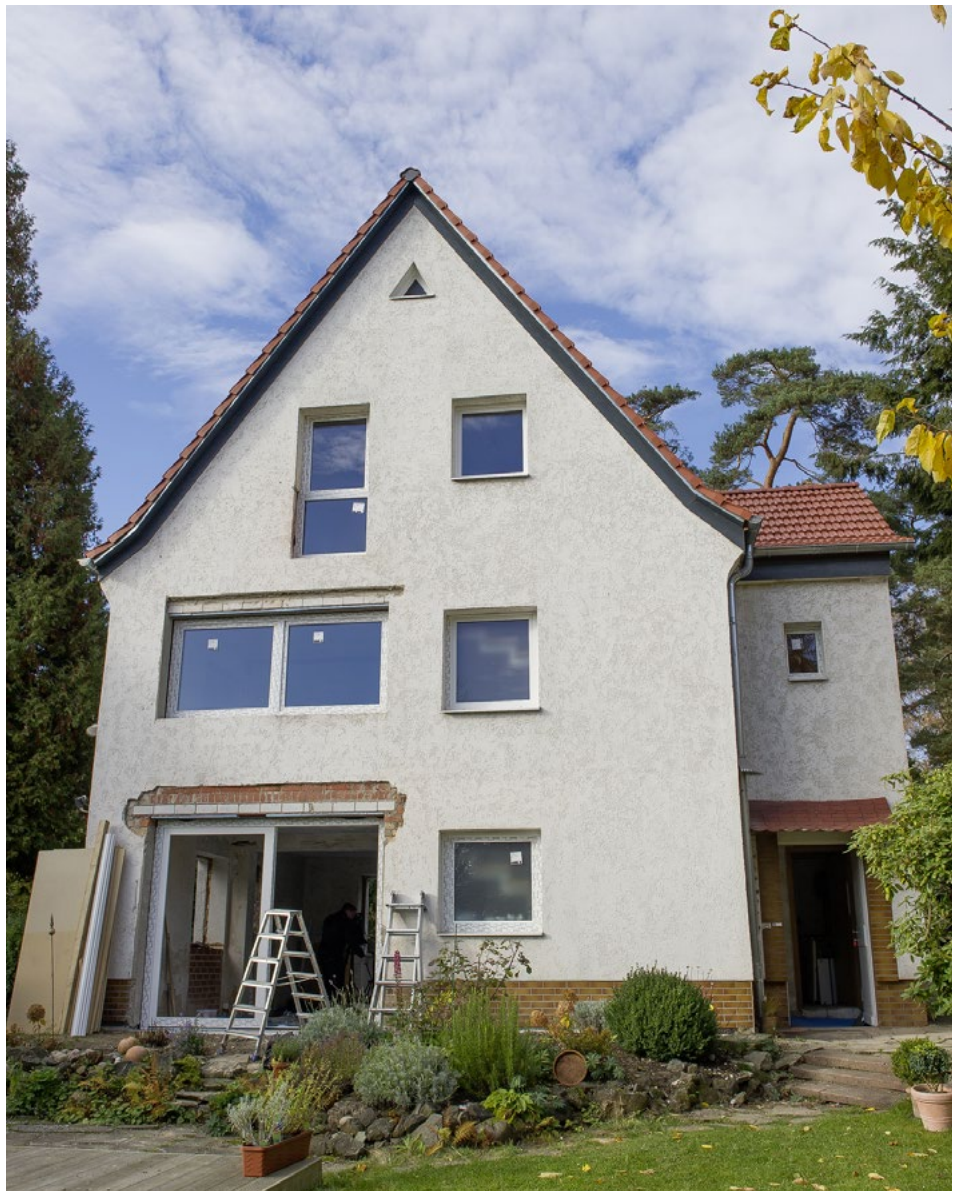
Bild 1: Bei der Sanierung nachträglich eingebautes Element mit absturzsichernder Verglasung (Fenster im Dachgeschoss links) und Vergrößerung der Fensterflächen
