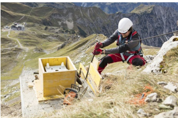
Schwerstarbeit in steiler Höhe: Die Firma HTB ist auf Hochgebirgsbau spezialisiert.
