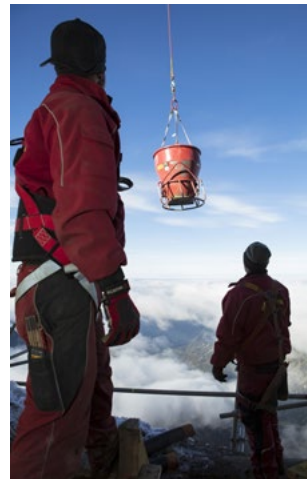
Zwei Arbeiter nehmen am Nordwandsteg eine Ladung Beton in Empfang.
