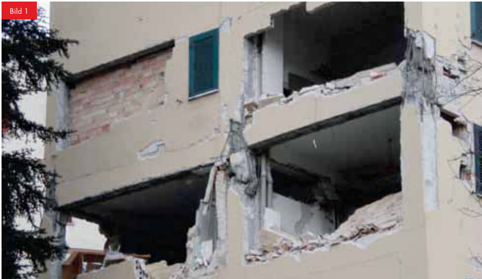
Bild 1: Versagen von Stahlbetonrahmen infolge eines Erdbebens (Italien 2009, Foto: A. Brignola) Bild 2: Verstärkung von Rahmenendknoten Bild 2a Verstärkung mit Stahldiagonalen 4 Bild 2b Entwicklung der Verstärkung mit Stahldiagonalen 1 Bild 3: Kräfteübertragung durch die Stahldiagonale und die Dübel
